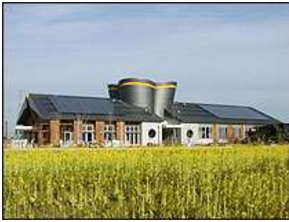
菜の花館の全景。屋根には30kwの太陽光発電を設置しています。
