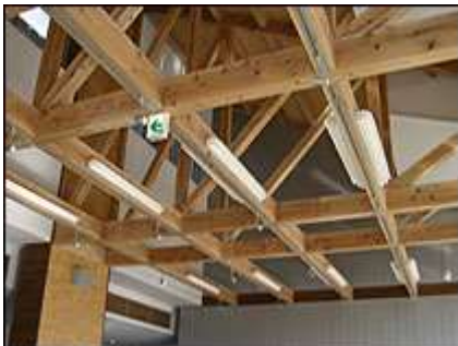
施設の一部は木造建築を取り入れています。
